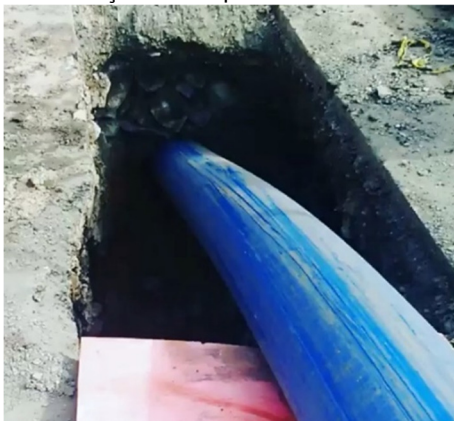
Troca de tubulação PEAD pelo Processo MND
